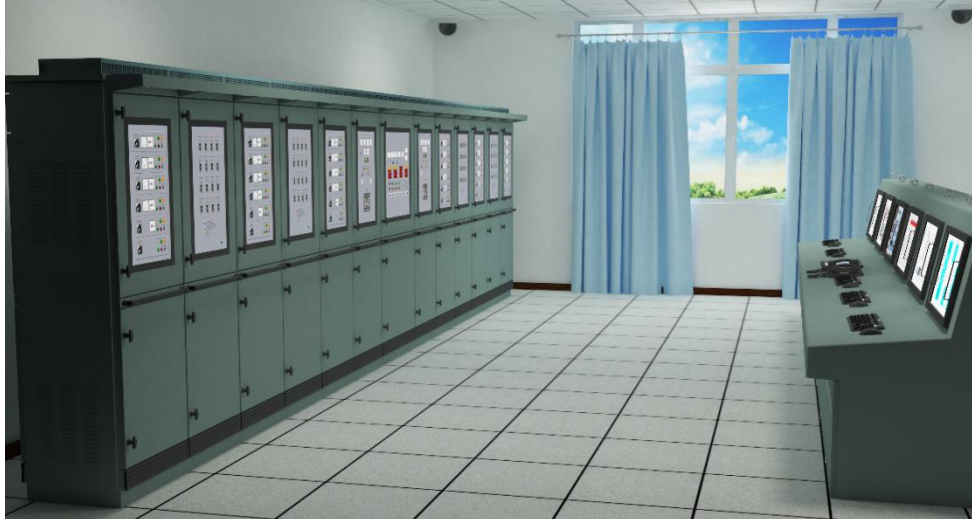
图 1 触控型集控台及配电板效果图
